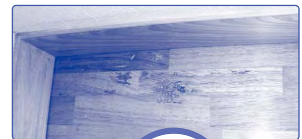
新築7年のフローリングがシロアリに…定期的な診断をお勧めします！
